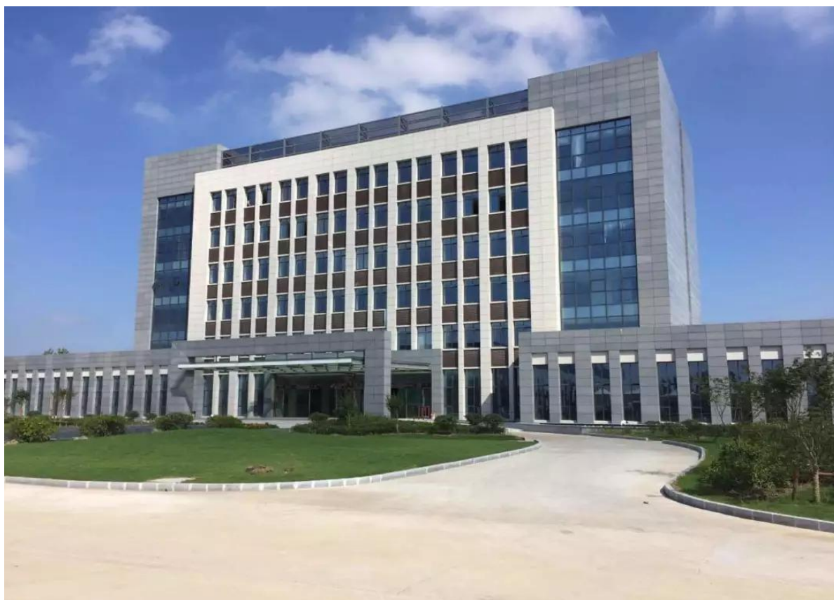
(江苏六甲科技办公楼)
